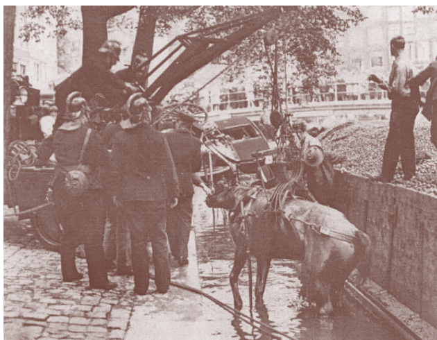
Het ophalen van een paard uit het water aan de Lauriergracht, op de achtergrond de huizen van de Prinsengracht Datering: augustus 1930 Vervaardigd door Vereenigde Fotobureaux N.V
